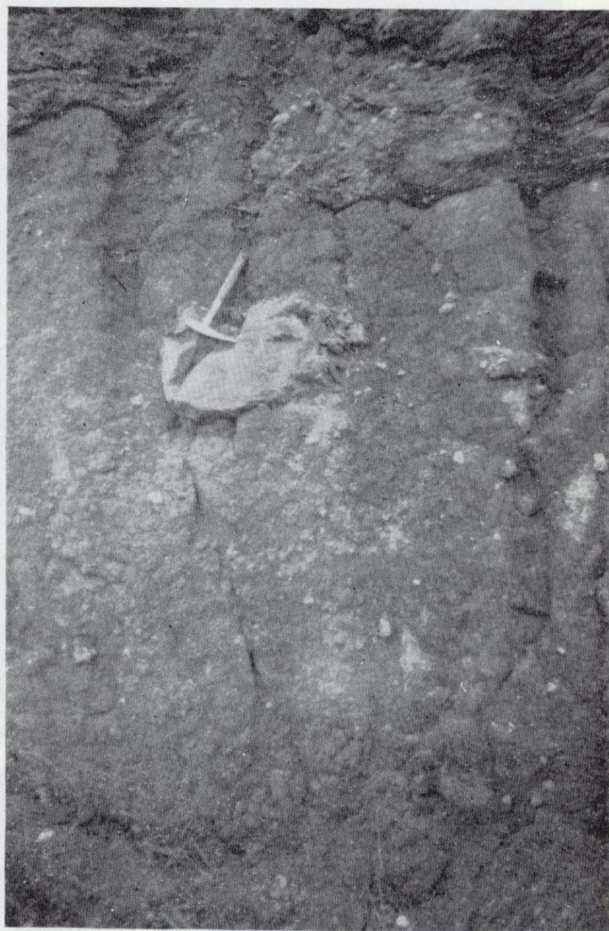
Foto 4.—Flujo de fango. Carretera Nacional 301. P. K. 353,5. Cieza.
